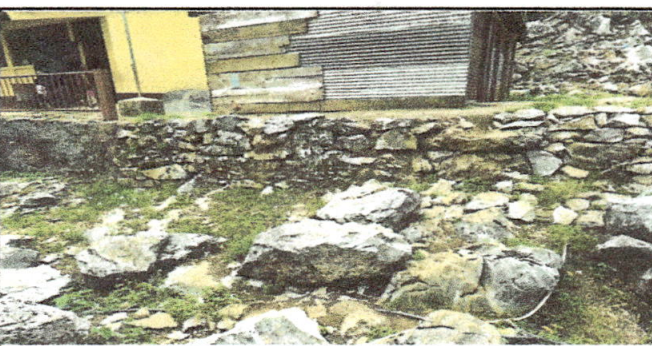
Foto 6: Continuación de gradas del establecimiento.
